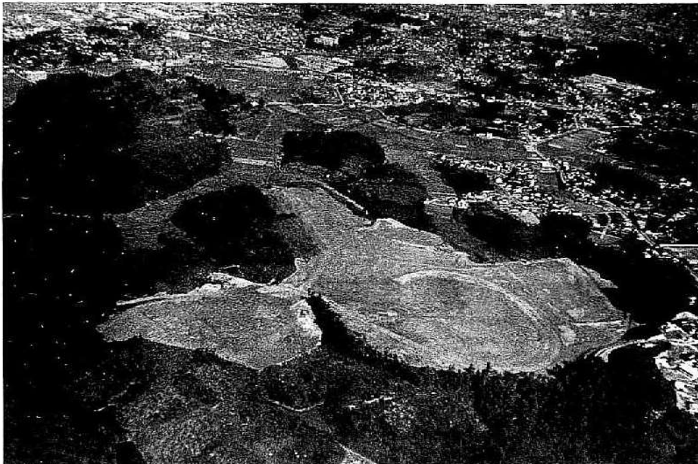
建設中の総合グラウンド
