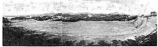
建設中の総合グラウンド
